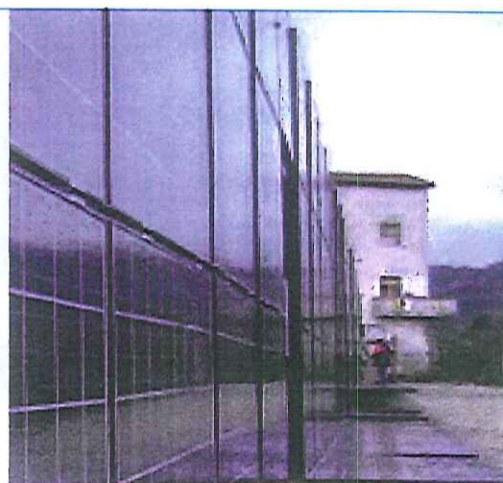
TIPOLOGIA SPECIFICA 3 (barriera acustica). Qualora la soluzione proposta fosse simile a quella rappresentata in figura il riconoscimento dell'integrazione parziale non sarebbe concessa perché è incongrua la posizione orizzontale dell'ultima fila in basso dei moduli.
