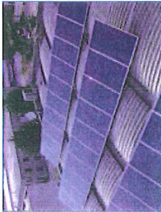
TIPOLOGIA SPECIFICA 1 (tetto piano). Qualora la soluzione proposta fosse simile a quella rappresentata in figura il riconoscimento dell'integrazione parziale non sarebbe concessa perché il tetto non è piano.
